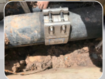
▶ PE Pipe Repair
